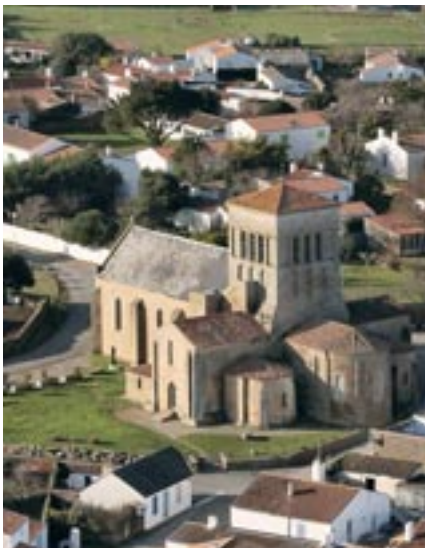
L'église de Saint-Sauveur va être rénovée.
